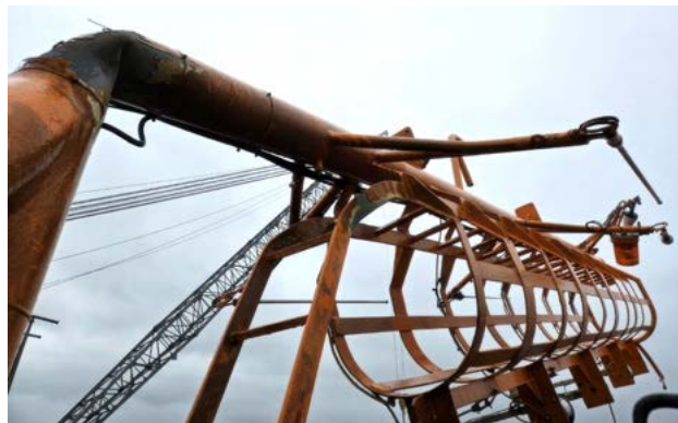
▲ Figuur 29: Schade aan de mast van de Eems Warrior. (Bron: Amasus Shipping)
