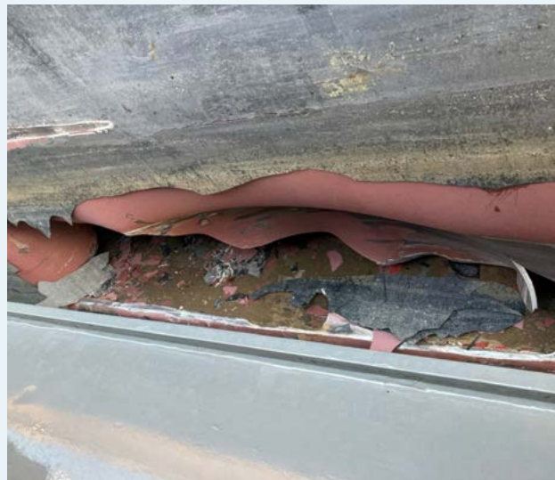
▲ Figuur 28: Scheur van 1 meter lang en 50 centimeter breed in de romp aan stuurboord. (Bron: Union Shipping)
