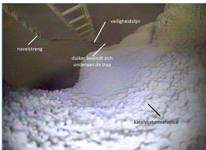
◀ Figuur 5: De duiker is niet zichtbaar op de foto, maar bevindt zich volgens betrokkenen aan de onderzijde van de ladder. Naast de ladder is aangekoekt katalysatormateriaal zichtbaar. (Bron: Video T.I.M.E.)
