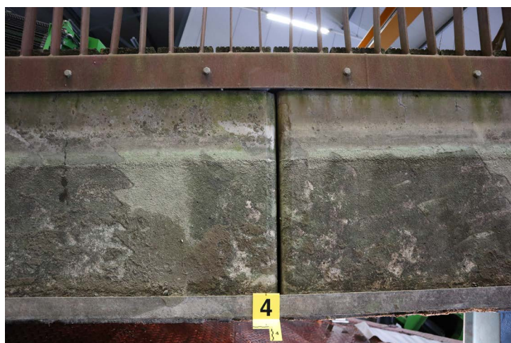
◀ Figuur 4: zijaanzicht van de twee drijflichamen met de zichtbare tekening van de waterlijn.
