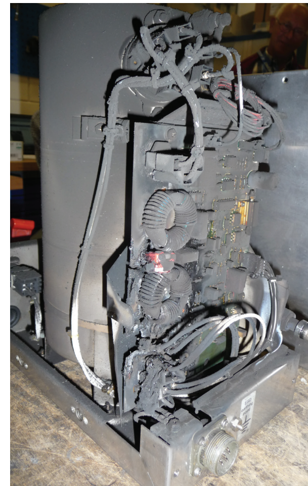
De beschadigde waterverhitter.
