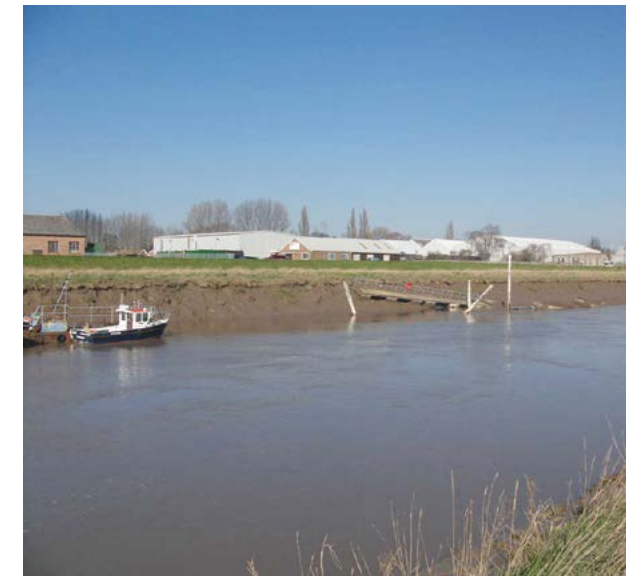
Het gezonken ponton. (Foto: Marine Accident Investigation Board)
