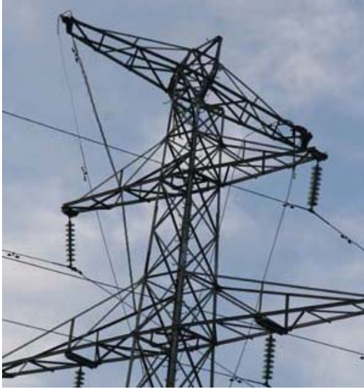
Figuur 2: Hoogspanningsmast in Haaksbergen: een getordeerde toptraverse en gebroken bliksemraden (bron: OvV d.d. 12-12-2005)
