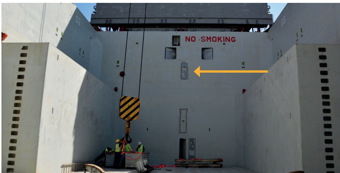
Figuur 7: Vergelijkbare situatie van de deuren aan de andere zijde van het ruim. De matroos is uit een deuropening op de hoogte van de pijl in het ruim gevallen.
