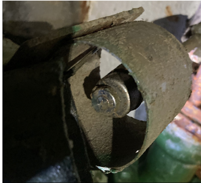
Figuur 25: Onderkant lenssensor – Visverwerkingsdek.
