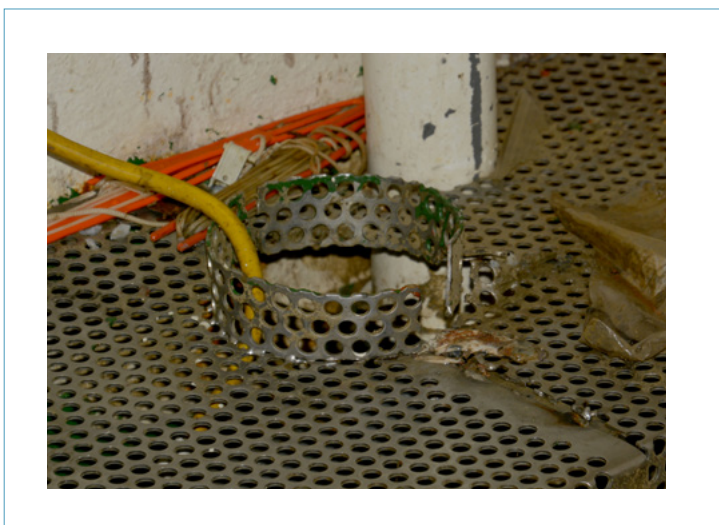
Figuur 19: Lenspomprooster ter hoogte van de lenspomp (visverwerkingsdek).
