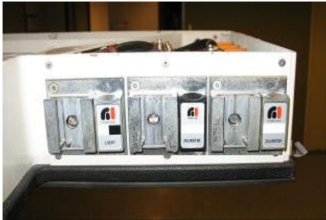
Figuur 5: Contactpunten op de pendel voor gasslangen aan te koppelen vanuit toestel
