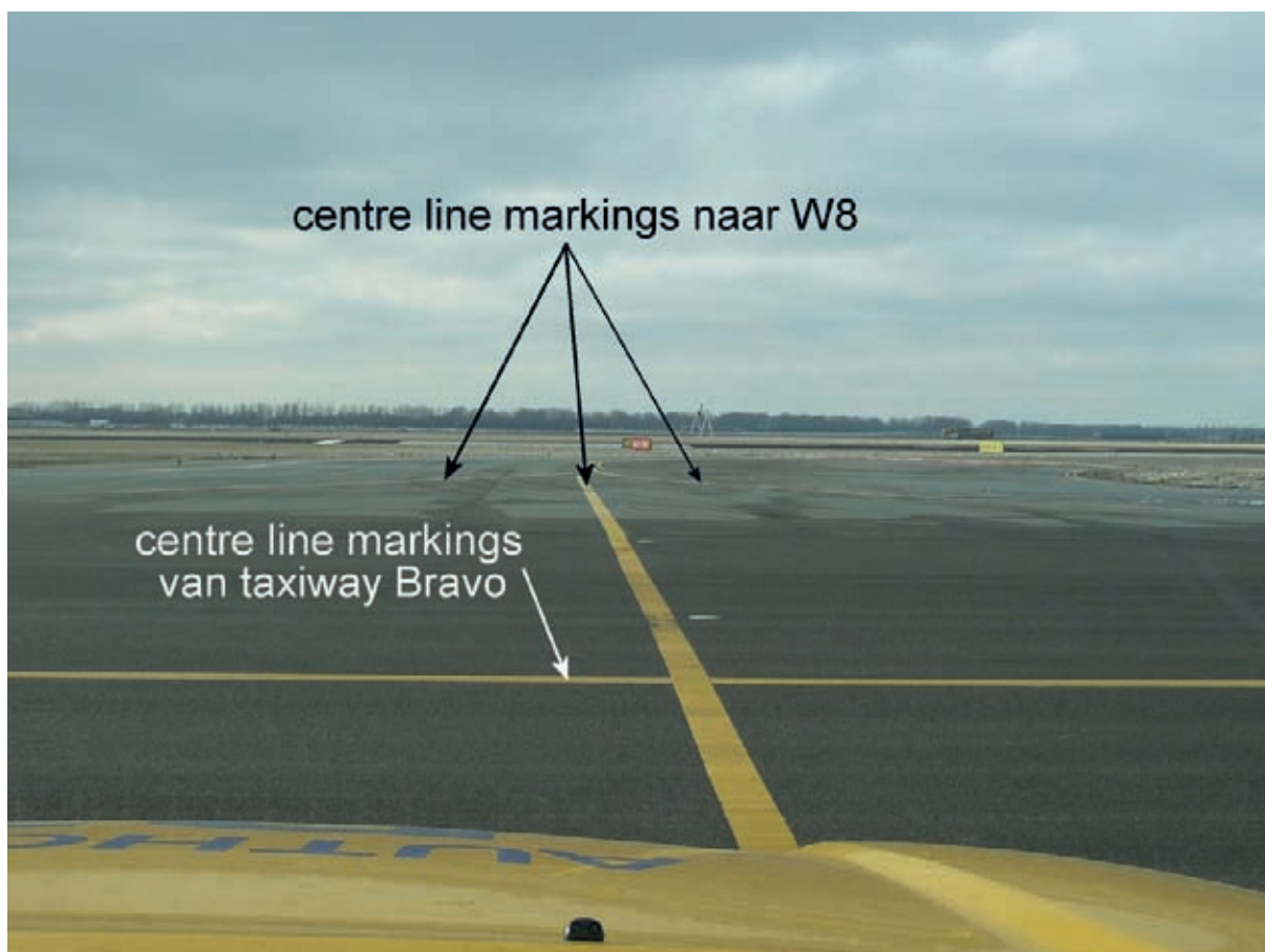
Figuur 7: gele markeringstrepen (centerline markings) in het daglicht op het kruispunt van doorsteek A25 met taxiway Bravo kijkend in de richting van startbaan 36C
