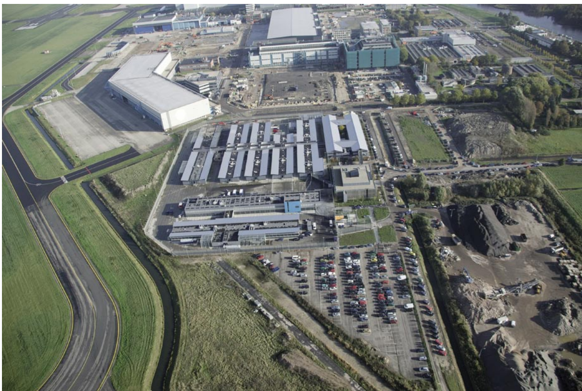
Figuur 24: Luchtfoto cellencomplex en omgeving
