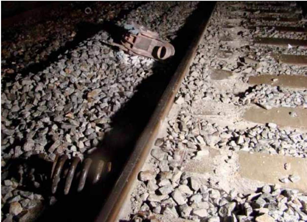
Figuur 13: Op deze foto zijn de beschadigingen te zien die door het linker wiel van het ontspoorde wielstel zijn veroorzaakt in de betonnen dwarsliggers. Links naast de spoorstaaf liggen de warmgelopen aspot en een van de vier bijbehorende veren.
