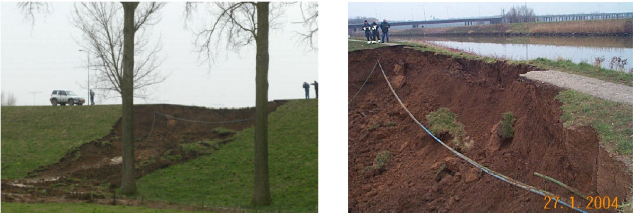
Figuur 9: Weergave dijkverzakking bij Stein (Bron: RWS)
