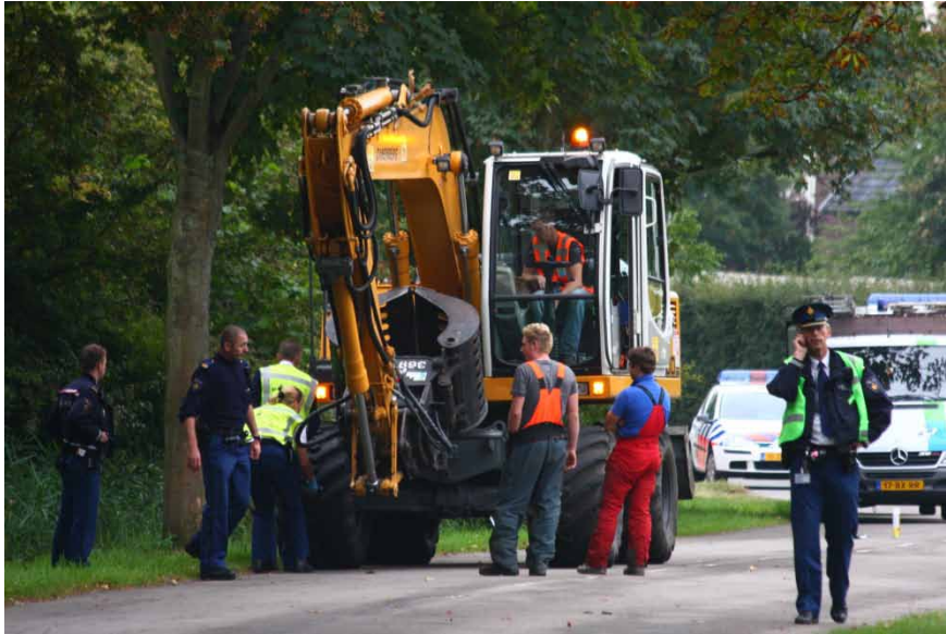
Figuur 11: De graafmachine op de ongevalslocatie (foto: www.rowinvandiest.nl )
