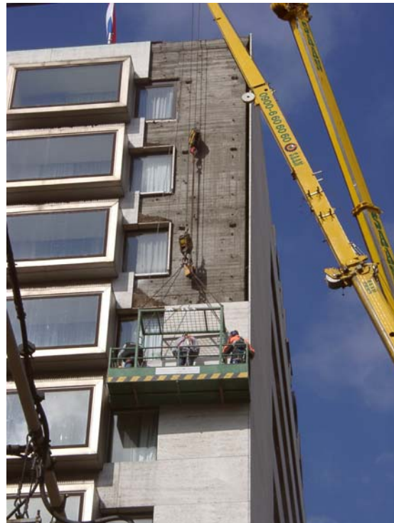
Figuur 2 Verwijdering van andere gevelplaten
