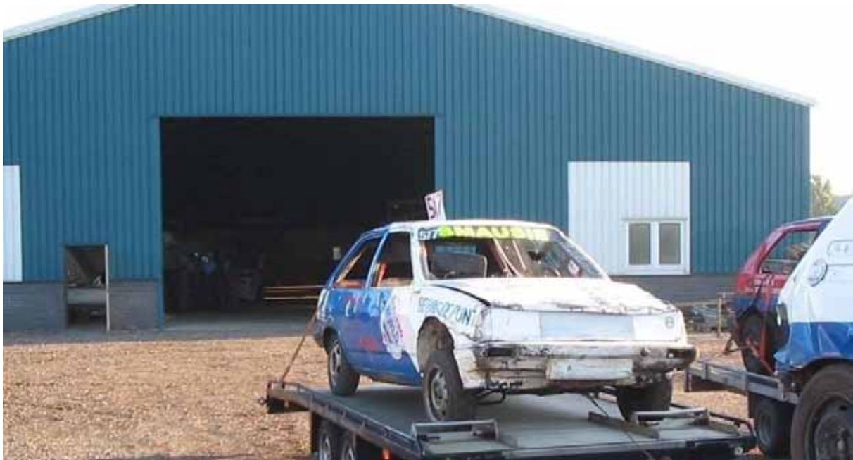
Foto 1 Voorgevel loods met geopende overheaddeur
