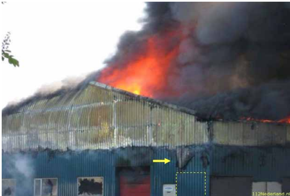
Foto 4 Achtergevel van de loods tijdens de volledig ontwikkelde brand. De gele pijl wijst naar het 'V'-patroon op de buitenwand. De gele stippellijn geeft de contouren weer van de meterkast die zich achter de wand bevindt.
