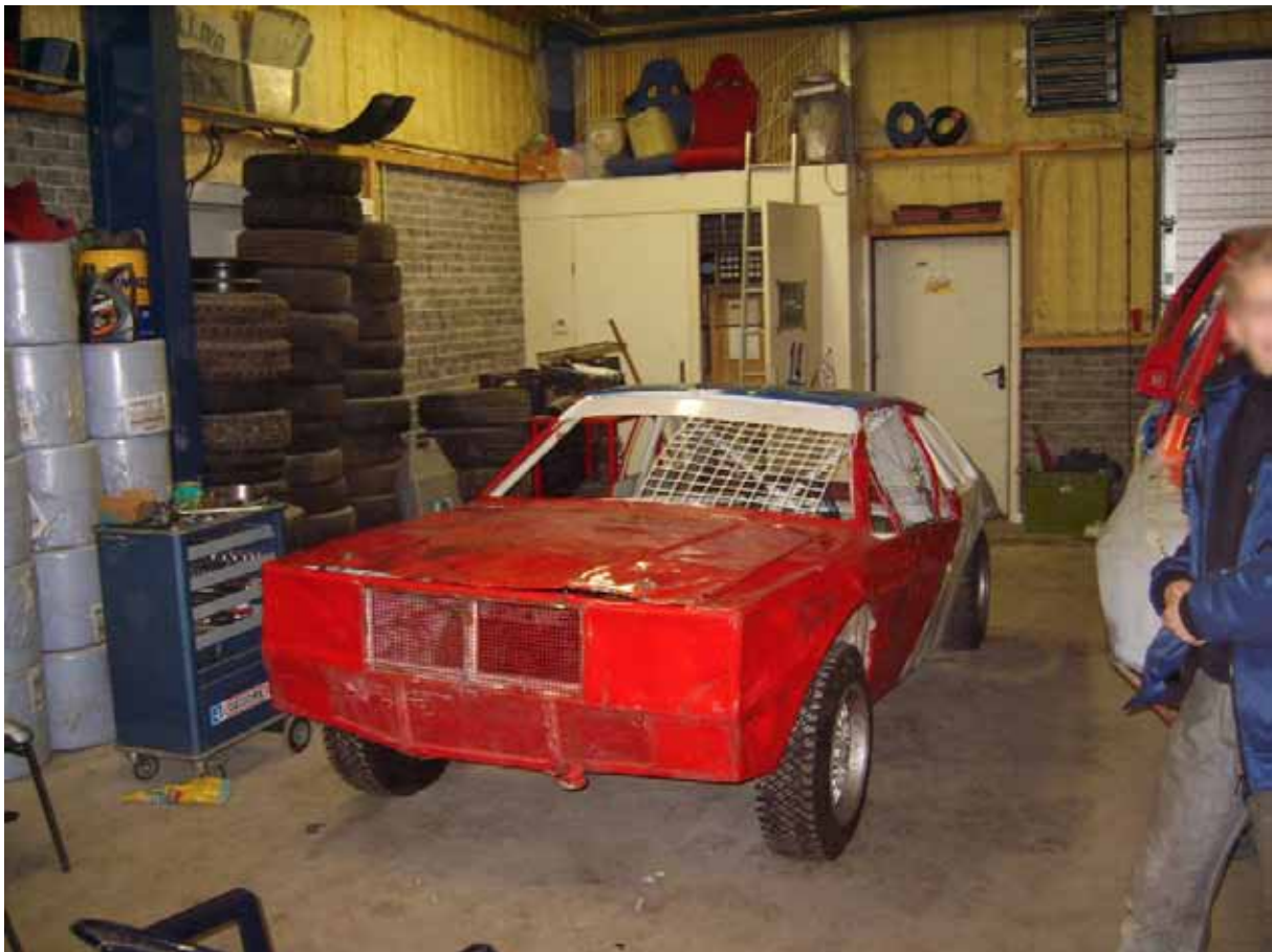
Foto 3 Het interieur van het magazijn. Links achterin, met openstaande deur, de meterkast waar de brand begonnen is. De geelachtige bekleding van de hogere delen van de muren is onbedekt polyurethaanschuim.
