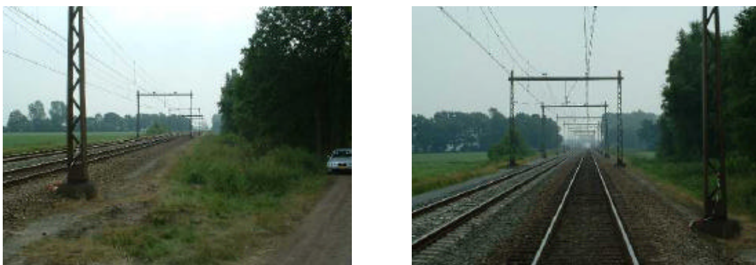
Figuur 4-3: Het coulisse-effect. Op de linker foto wordt de zichtbaarheid van de trein in punt A negatief beïnvloed door de betonnen hoogspanningportalen. Rechts het zicht vanuit B.
