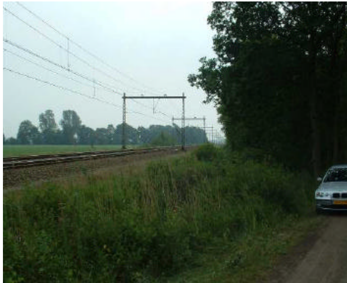
Figuur 4-5: Zicht op de spoorbaan op ongeveer 20 meter van de overweg; tenminste 10 hoogspanningsportalen zijn zichtbaar ( \pm 500 m).
