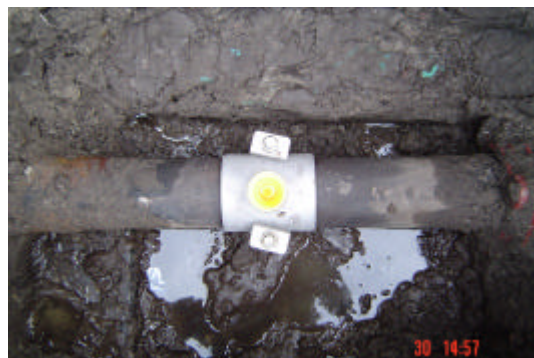
Figuur 2: Blaasgatzadel na de reparatie
