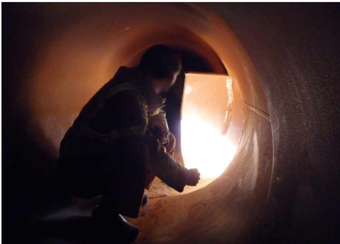
Figuur 2: Binnenkant laadpijp, waar gelast werd.
