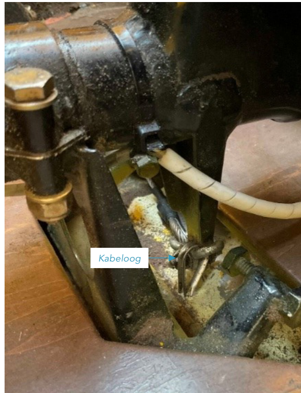
Kabeloog zonder kabel
