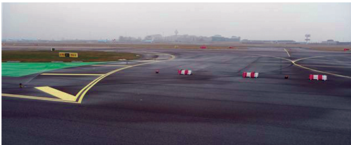
Figuur 4: Intersectie W11 (februari 2013) gezien vanaf het westen in de richting oost. Let op de aangepaste belijning en groene verdrijvingsvlakken zoals aangegeven in figuur 3, onder. De infrastructurele aanpassingen zoals gedaan door de luchthaven in juni 2012.
