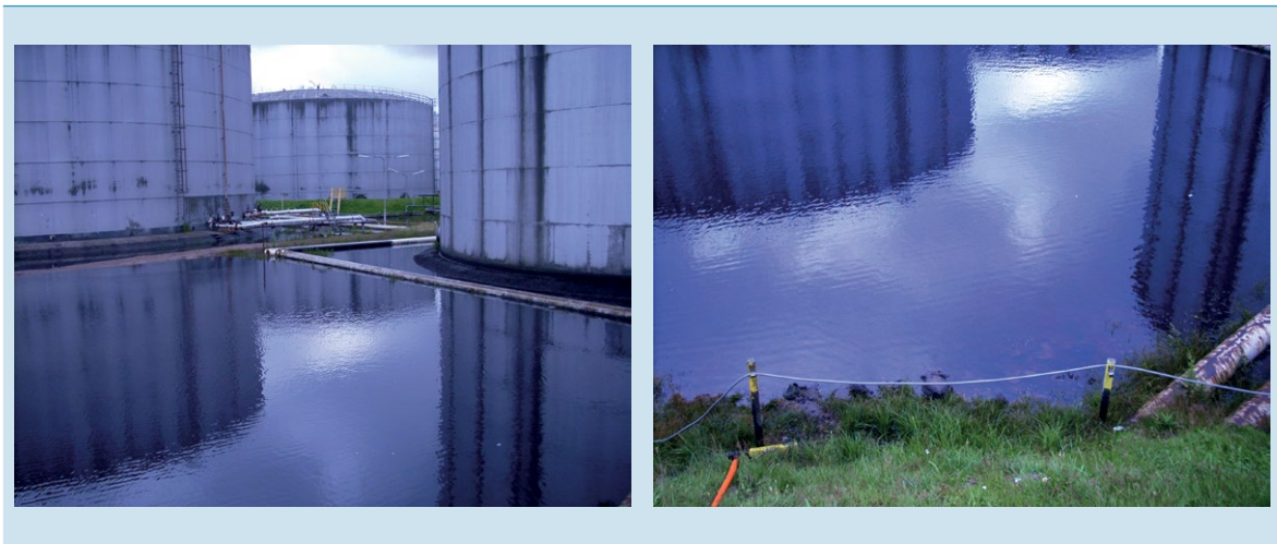
Figuur 1: Foto's van de situatie in de vroege ochtend na de lekkage. De tankput staat vol met gasolie. (Bron: omgevingsdienst Noordzeekanaalgebied)
