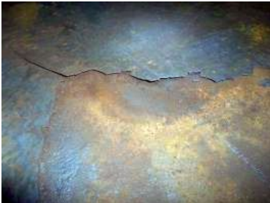
Figuur 9: Coating van de tank (binnenzijde). (Bron: EuroTank)
