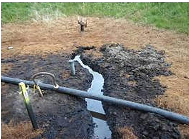
Figuur 5: Verontreinigde tankput nadat de gasolie uit de put was gezogen. (Bron: EuroTank)
