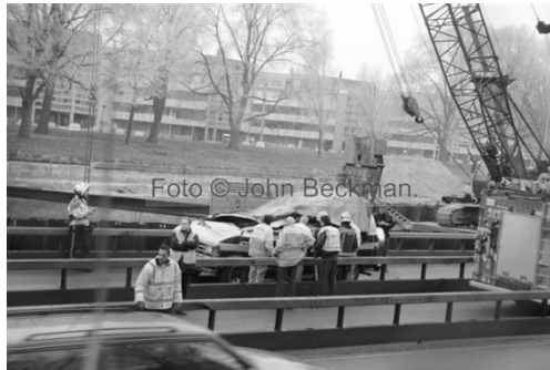
Een damwand valt als gevolg van het onjuist toepassen van een hijsmiddel. Het effect bevindt zich binnen de BVZ, maar een auto (publiek) was door een hek binnen de BVZ gereden.
