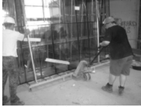
Een glasbok met glasplaten valt als gevolg van een onjuiste hijsmethode. Het effect strekt zich uit tot vijfmaal de BVZ.
