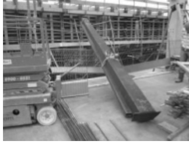
Een stalen balk valt als gevolg van het onjuist toepassen van hijsgereedschap. Het effect bevindt zich in de BVZ.
