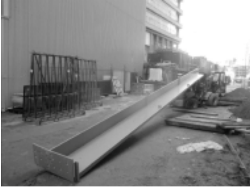
Een stalen kolom valt als gevolg van de toepassing van een onjuist hijsgereedschap. Het effect bevindt zich in de BVZ.
