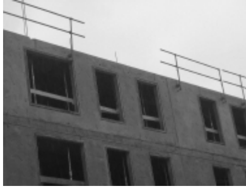
Een leuning valt tijdens het bevestigen ervan. Het effect bevindt zich in de BVZ.
