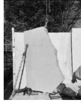
Een betonnen wand valt als gevolg van een onjuiste montagemethode. Het effect bevindt zich in de BVZ.
