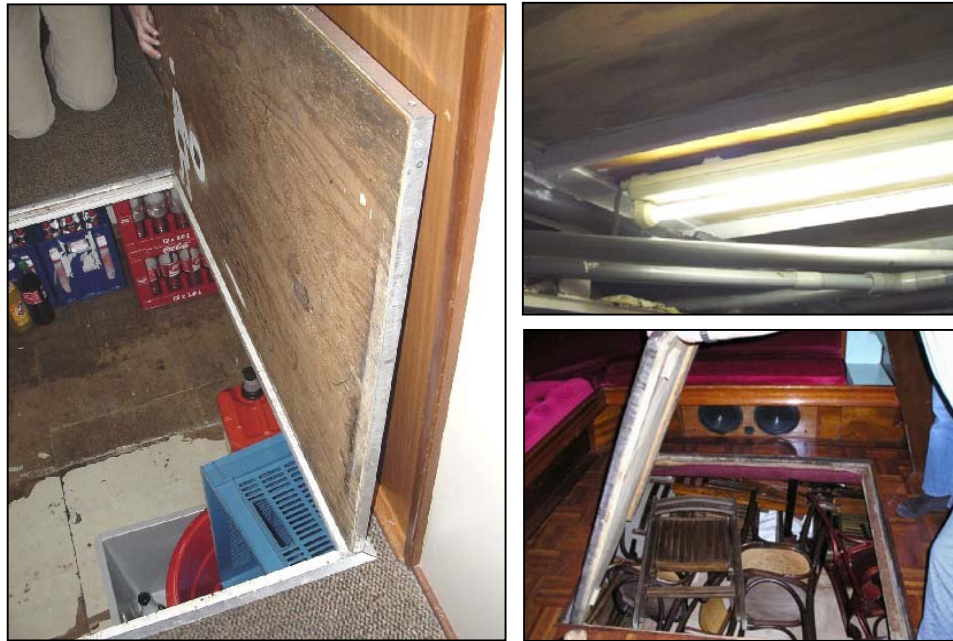
Figuur 13 Opslag en verlichting onder houten vloer bij oude schepen
