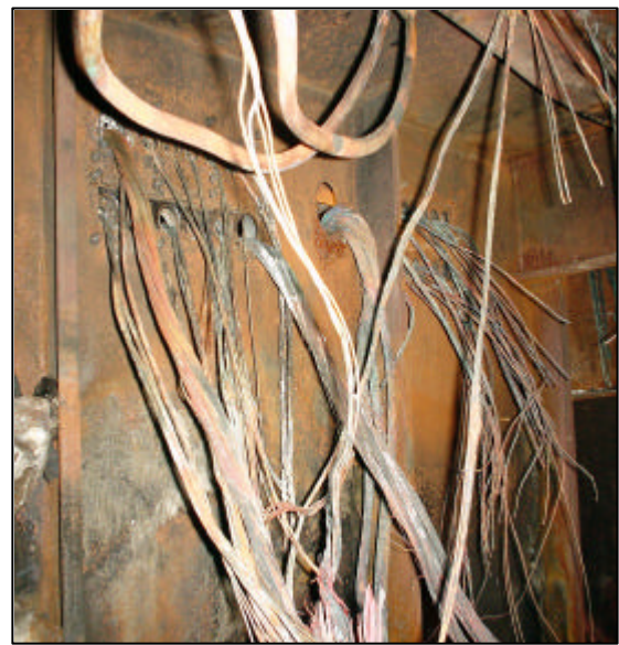
Figuur 5: Foto's van de kabeldoorvoeringen na de brand. De openingen tonen aan dat de kabeldoorvoeringen niet brandwerend uitgevoerd waren (Bron: Onderzoeksraad).
