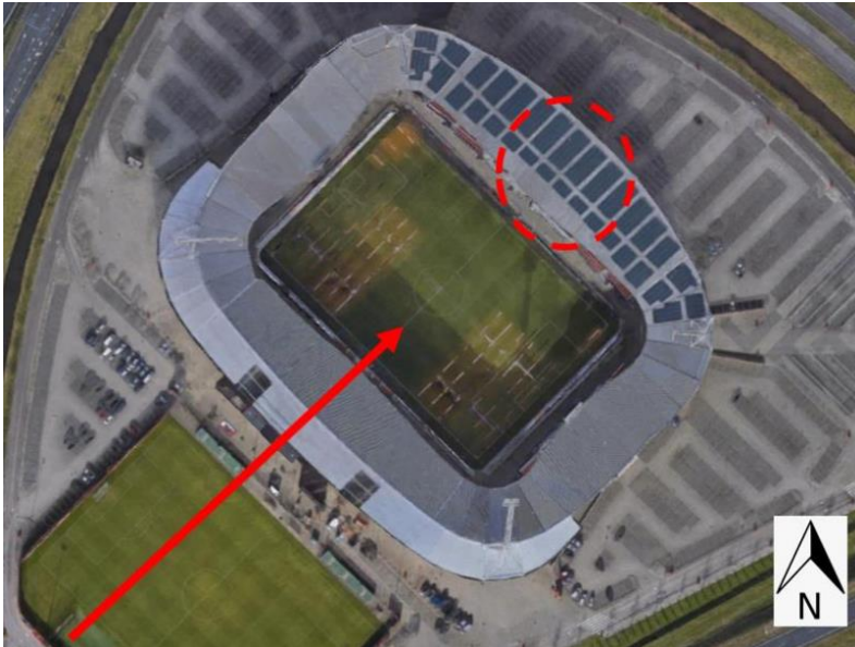
Figuur 3: Ligging van AFAS Stadion waar de sterkste windrichting met een rode pijl is aangegeven en het ingestort deel rood is omcirkeld. [Bron: RHDHV-rapport Bijlage B Figuur 3]
