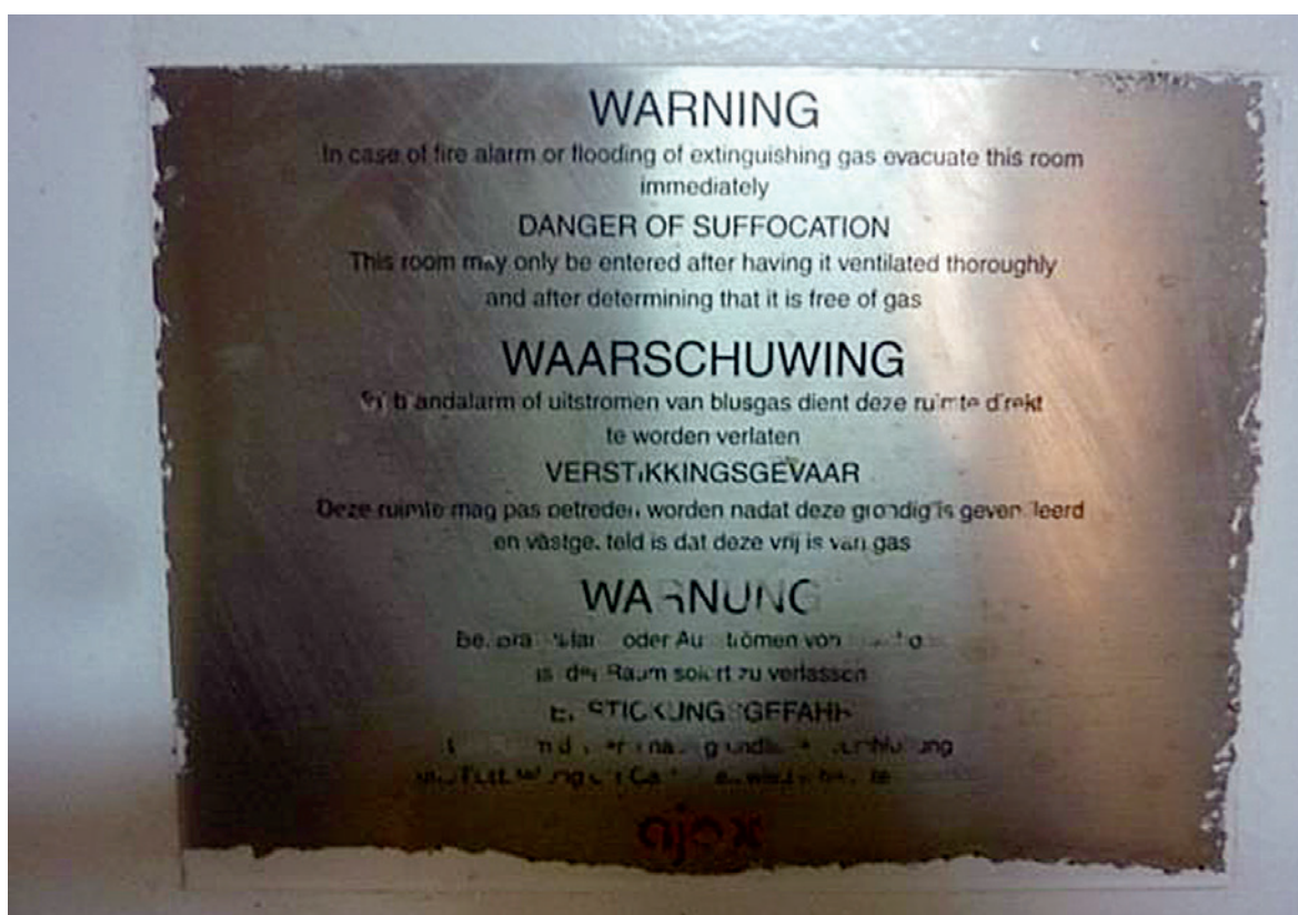
Figuur 4: Waarschuwing op de toegangsdeuren tot de schacht. (Bron: van Ameyde Marine)
