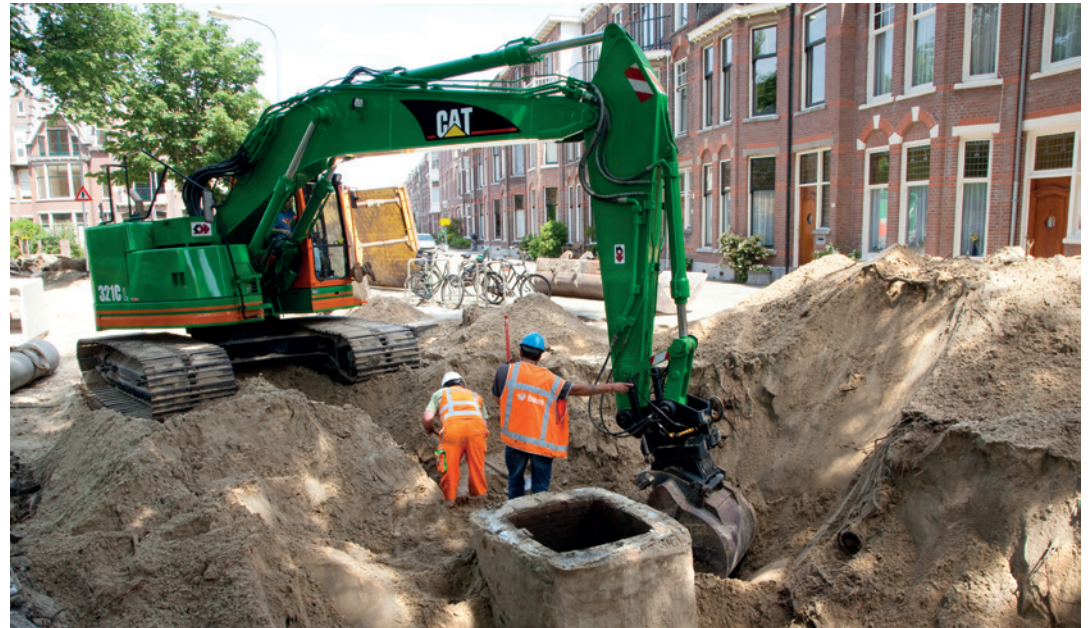
Graafwerkzaamheden in een straat.
