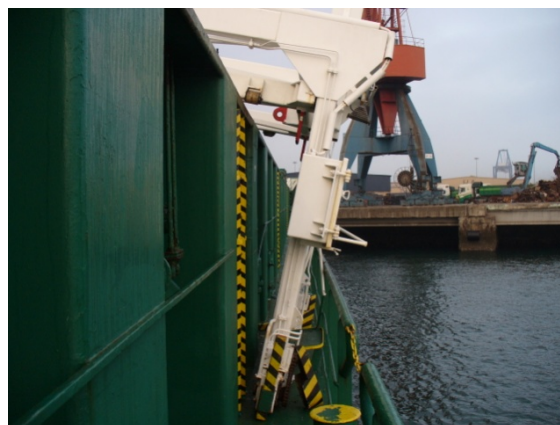
Foto 5: Positie van de luikenwagen aan stuurboordzijde in het gangboord
