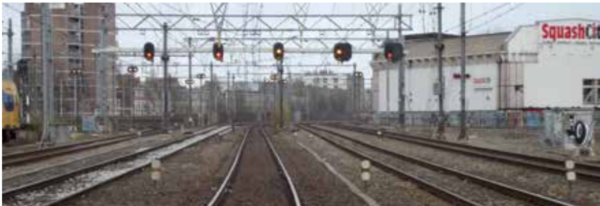
Figuur 4: Sein 606 is het middelste van vijf seinen op een rij en staat opgesteld net na het verlaten van Amsterdam Centraal. De foto is genomen op de dag na de botsing. Foto: Onderzoeksraad voor Veiligheid.
