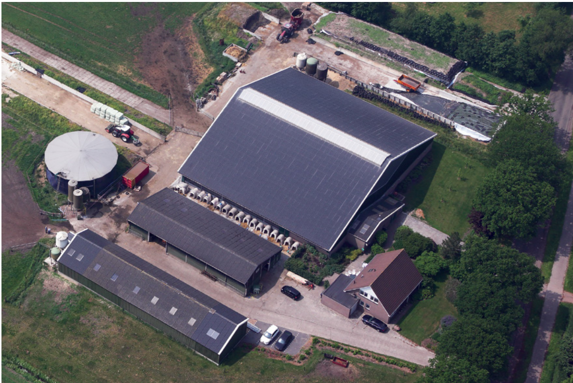
Figuur 1: Bovenaanzicht van het melkveebedrijf, met in het midden de stal en links de mestsilo. (Bron: KLPD)
