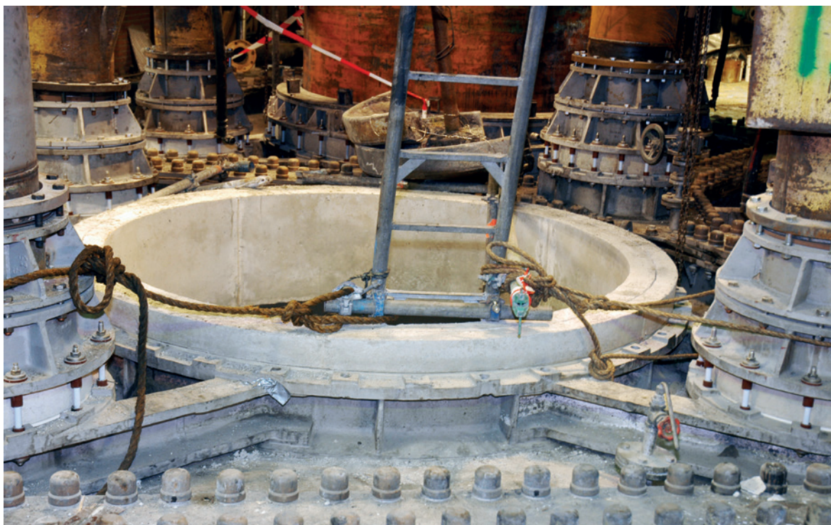
Figuur 4: De elektrode opening van de fosforoven met daarop zichtbaar de ladder die gebruikt werd om in de oven te komen. (Bron: PV technisch onderzoek FO, pv nummer BVH 2009040860-6)
