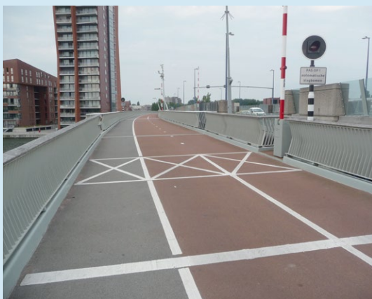
Foto 4: Eerste slagboom en landverkeerssein.
