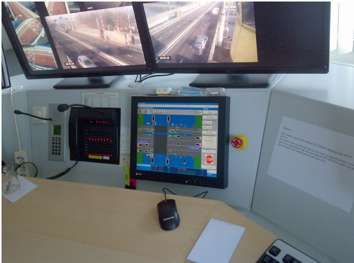
Figuur 10: Het SCADA-scherm met daarboven de beeldschermen met camerabeelden. (Foto: Onderzoeksraad voor Veiligheid)
