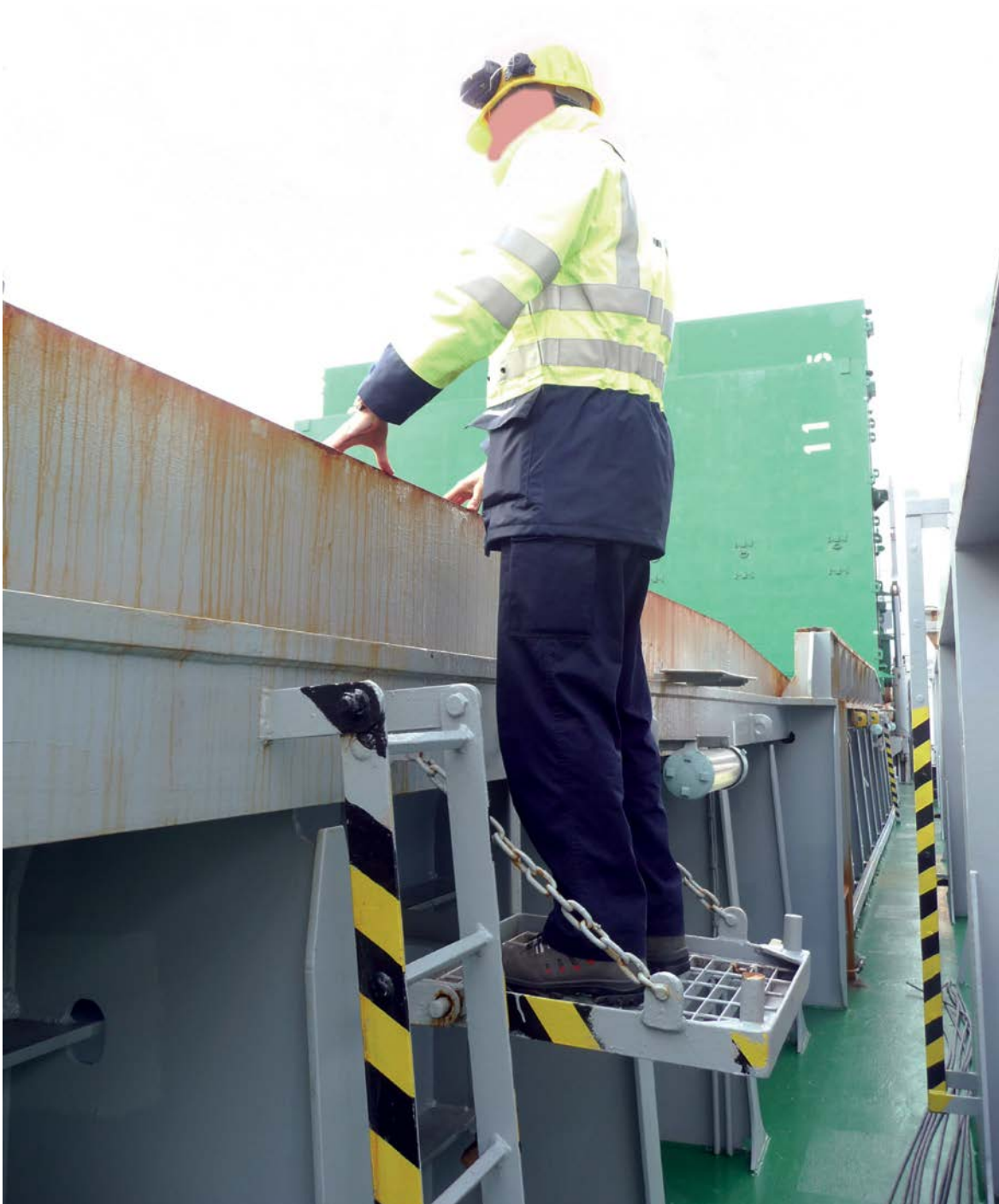
Figuur 5: Reconstructie van de opstelling op het stuwadoorsplatform. De valbescherming is niet geplaatst. De positie bevindt zich aan de achterzijde van het voorste ruim. (Bron: Onderzoeksraad voor Veiligheid)
