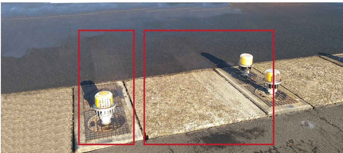
Figuur 1: Sporen van het hoofdlandingsgestel (gemarkeerd met rood kader) zichtbaar op de baanrand na het voorval. De drie beschadigde lampen zijn inmiddels vervangen. (Foto: Amsterdam Airport Schiphol)
