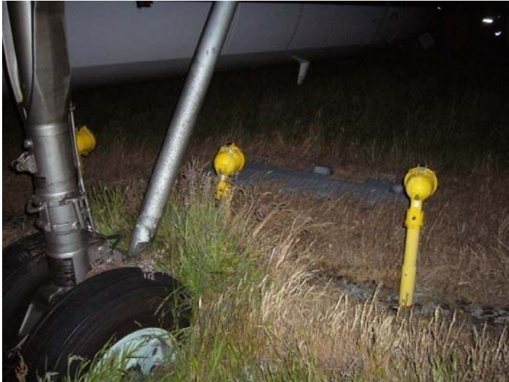
Illustratie 6: rechterhoofdlandingsgestel Fokker 50 nabij de betonnen constructie
