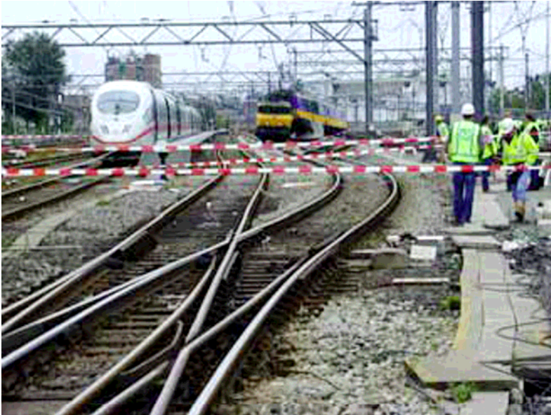
Afbeelding 7. Op de voorgrond wissel 57A in rechtsleidende stand met daarna de tegenboog naar links.
