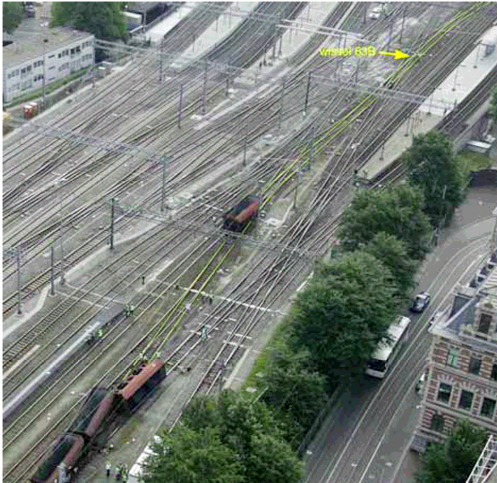
Afb.2 Defecte wissel 63, rijweg en eindpositie ontspoorde wagens
