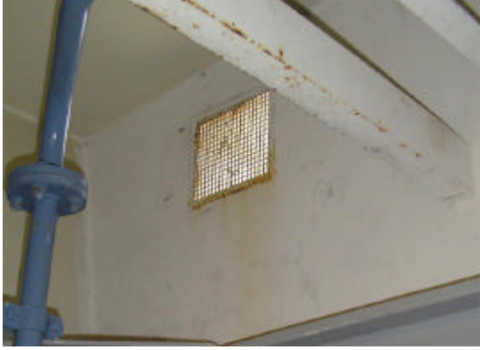
Afbeelding 8a. Een ventilatioerooster
