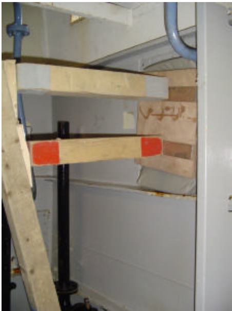
Afbeelding 2a. V-schoring tegen scheur
