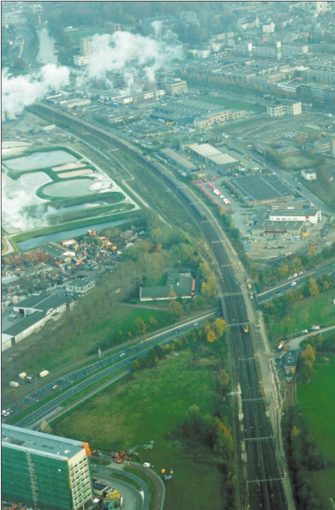
Afb.4. De ongevallocatie in Breda. De botsing vond plaats net voorbij het viaduct in de spoorbaan naast de schaftkeet. De werkzaamheden werden uitgevoerd naast de spoorbaan rechts beneden op de afbeelding. De trein staat op de plaats, waar hij tot stilstand kwam.
