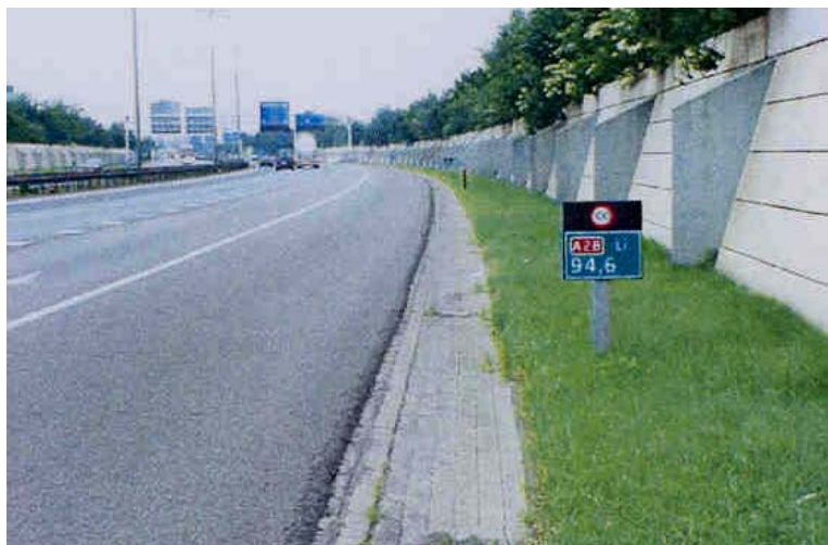
Figuur 1: Het geluidsscherm langs de A28 bij Zwolle. Bron: Bouwdienst Rijkswaterstaat.
