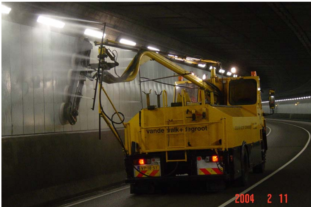
Afbeelding 9: Wasvoertuig in de IJtunnel in de tunnelbuis die voor het verkeer is afgesloten. Bron: RvTV.
