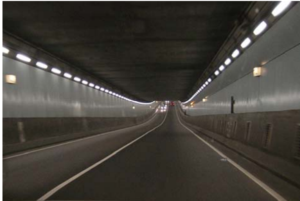
Afbeelding 11: Verkeer IJtunnel tijdens werkzaamheden uit twee richtingen door één tunnelbuis. Bron: RvTV.
