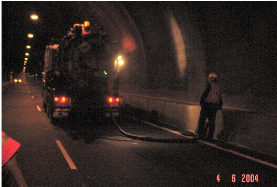
Afbeelding 10: Schoonmaak van afvoerputjes in de Westerscheldetunnel. Bron: RvTV.
