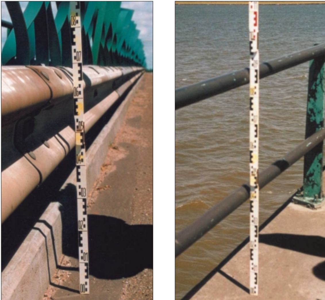
Figuur 3: Linkerfoto: de overgang naar het verhoogde betonnen gedeelte met daarop de zijvangrail, gezien tegen de rijrichting in.
