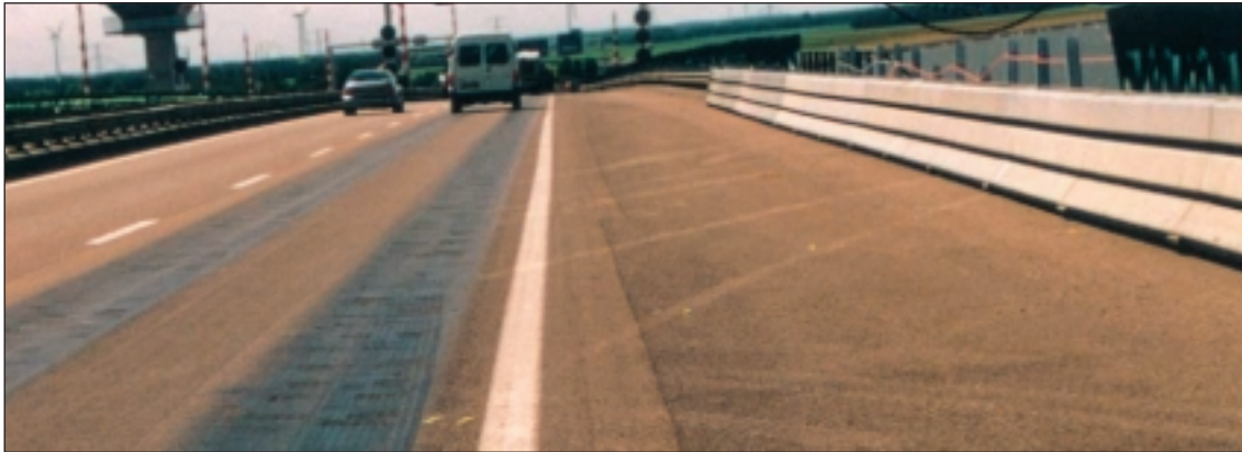
Figuur 12: Tijdelijke afscherming van de opening in de zijvanrail en de brugleuning. Bron: politie Flevoland-Noord.
