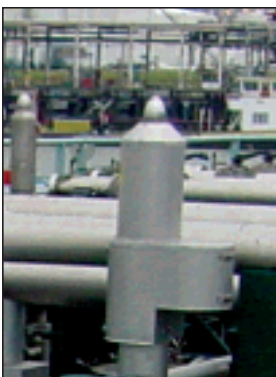
Figuur 4: Snelafblaasventiel
