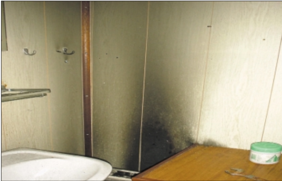
Figuur 2: Roetspoor op de achterwand van het achterverblijf
