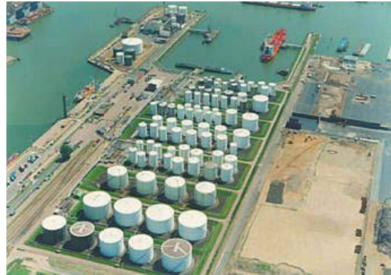
Afb. 4 De opslag faciliteit van Vopak Terminal TRR voor chemische stoffen in de Botlek te Rotterdam. Links in de openlucht bevindt zich het vulstation voor de ketelwagens.
