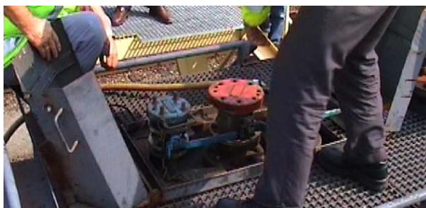
Afb. 6 Opname van vul- (rood) en retourleiding (blauw) en geopende beschermkap bovenop de ketelwagen gemaakt tijdens beproevingen na het incident (zonder acrylnitril dus zonder beschermende gaspakken).
