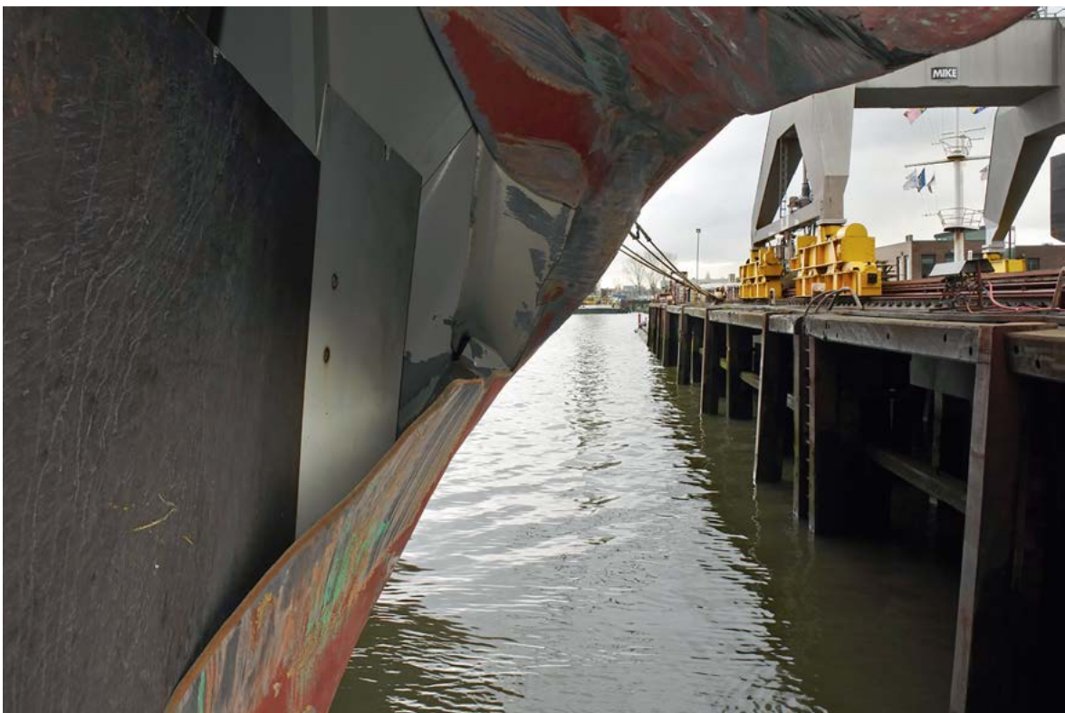
Figuur 5: Van binnenuit de Atlantic Jupiter, door het 15 meter lange gat naar buiten gekeken. (Bron: Onderzoeksraad voor Veiligheid)
