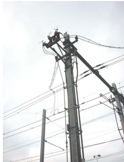
Afb. 8. Een portaal met twee normale bovenleidingschakelaars, één in geopende stand en één in gesloten stand. Door het wegknippen van de kabels kan de verbinding tussen bovenleiding en voeding worden verbroken
