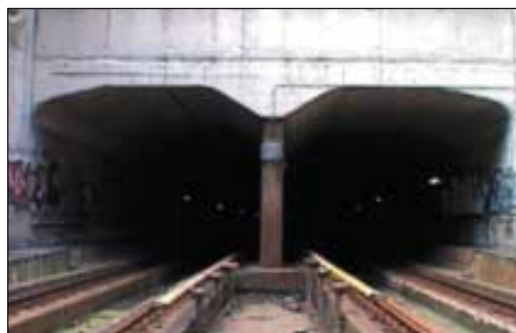
Afb. 3 De tunnelingang met aan weerszijden de looppaden en in het midden de pilaren.
