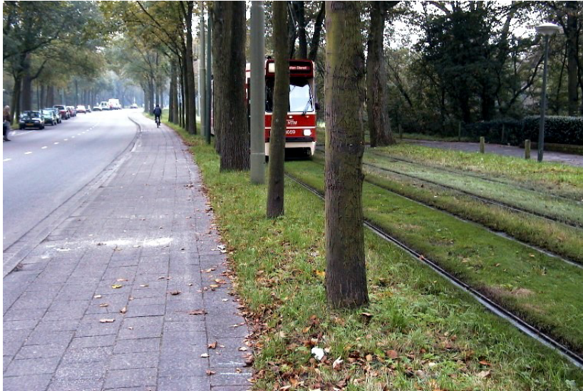
Figuur 3: zichtbeperking van de weggebruiker vlak voor de ongevallocatie door aanwezige bomen en masten naast de trambaan (Foto: Politie Haaglanden)
