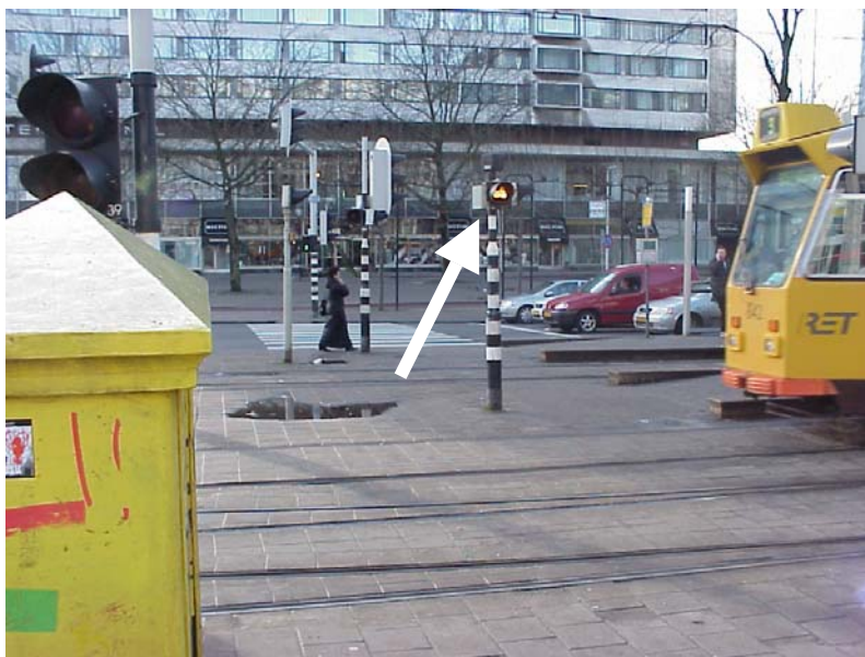
Figuur 8: Oranje knipperend tramwaarschuwingssysteem (zie pijl) op locatie Weena/Hofplein (zie hoofdstuk 3.2.1)
