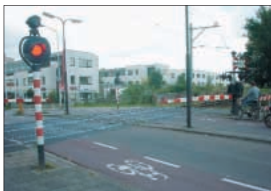
Figuur 12. Een overweg met Automatische Halve Overwegbomen (AHOB). Omdat het wegverkeer altijd de overweg moet kunnen verlaten is de overweg voor de helft open.
