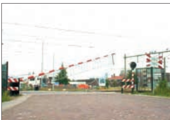
Figuur 11. Één van de laatste bestaande ouderwetse overwegen voorzien van sluitbomen en een wachter.
