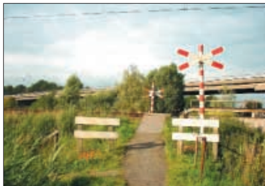
Figuur 14. Een overweg met Andreaskruis. Er bestaan nog 337 openbare overwegen alleen voorzien van een Andreaskruis. Situatie 2001.
