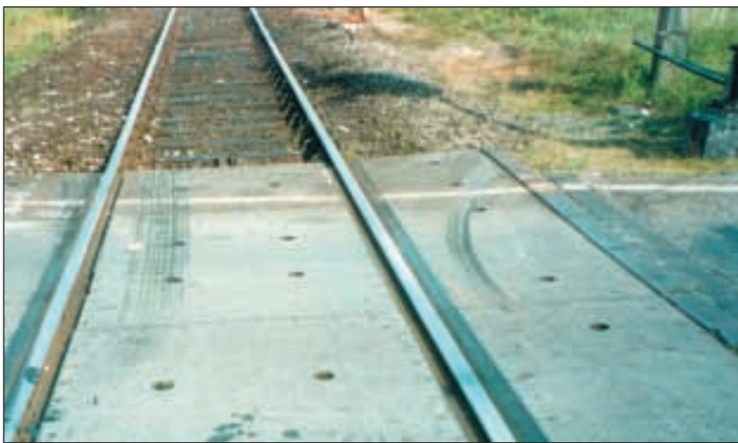
Figuur 5. De bandensporen van de bestelauto op de overweg lopen dwars op de rijrichting. De sporen van de achterwielen en van de voorwielen lopen niet parallel. De trein heeft de bestelauto al op de overweg in tweeën gereden.
